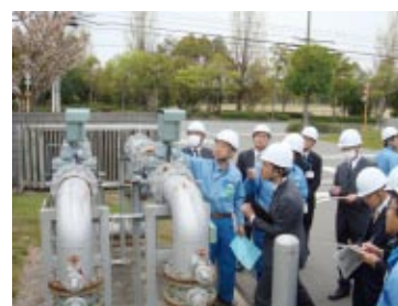
神戸サイトでの現場確認
